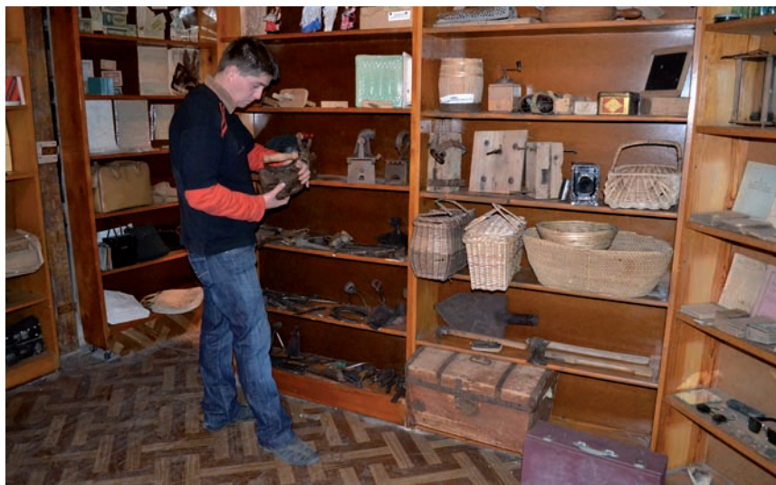
Gminny Ośrodek Kultury w Rzepienniku Strzyżewskim z siedzibą w Rzepienniku Suchym Przystosowanie poddasza budynku GOK na potrzeby prowadzenia izby regionalnej „Zapiecek”
