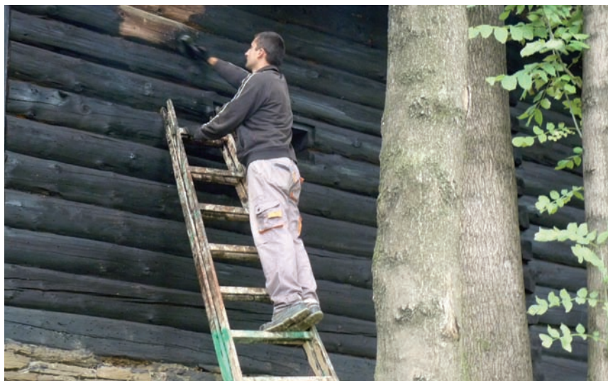
Urząd Miejski w Grybowie Impregnacja ścian zabytkowego obiektu przylegającego do Muzeum Parafialnego w Grybowie
